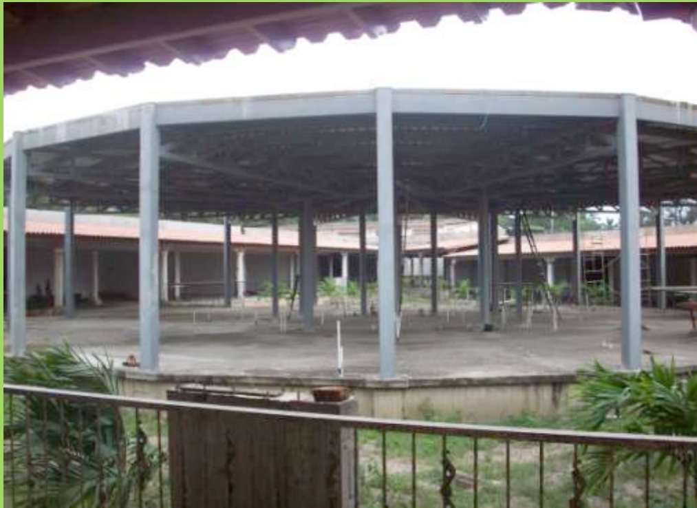
Foto de Feria de las Comidas: El Centro Comercial Oasis se encuentra en una fase de construcción de un 70%
